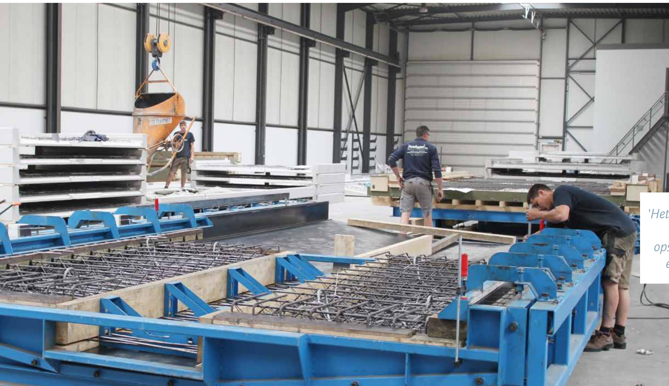
De bekisting van de prefab betonelementen is op maat gemaakt.
