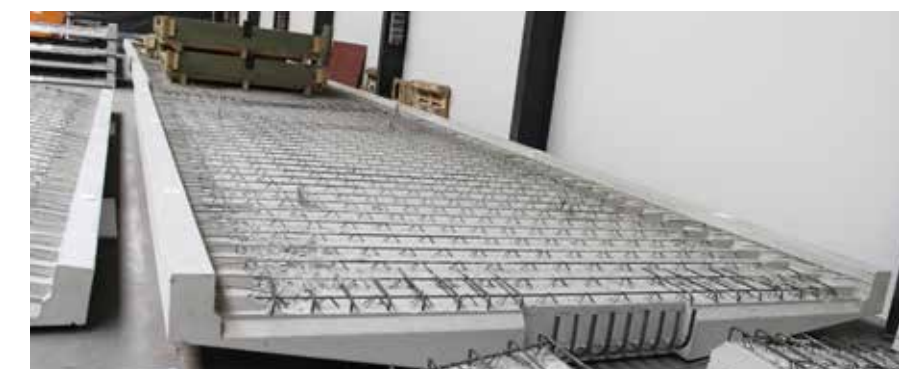
Het volledige brugdek wordt in één stortfase gemaakt.
